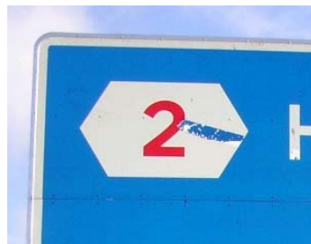
Tape har ødelagt folien
