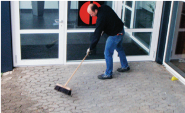
Fej underlaget grundigt som det første.
